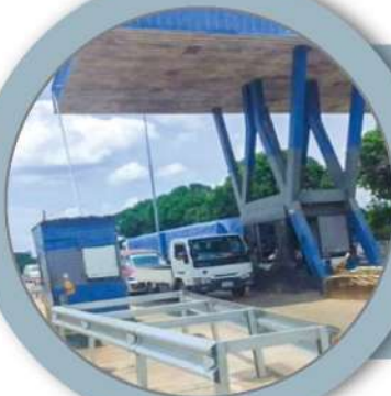
SERVICIO DE MEJORAMIENTO DE PROTECCIÓN VIAL DE LA ESTACIÓN DE PEAJE GUABIRÁ, REGIONAL SANTA CRUZ
