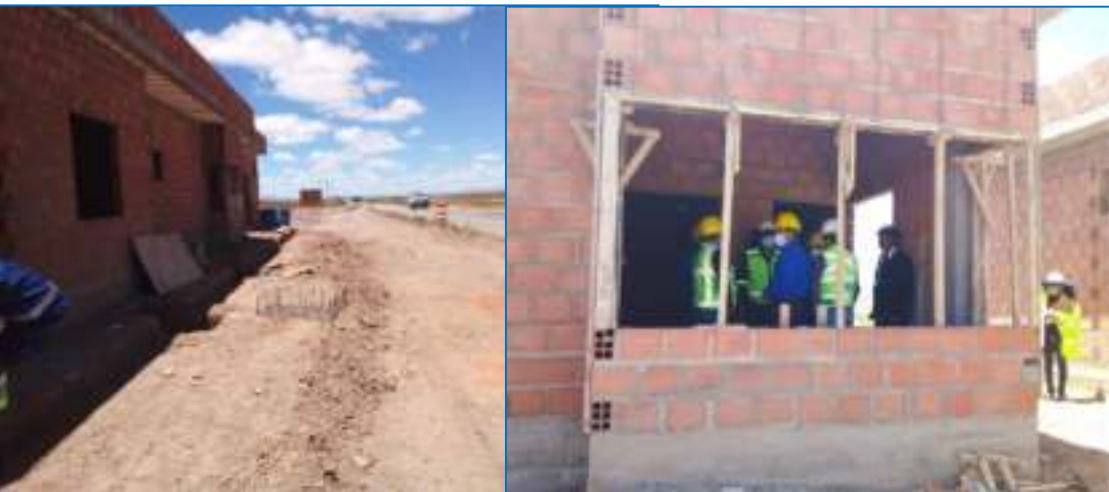
Proyecto ITS ESTACION CARACOLLO, Oruro
