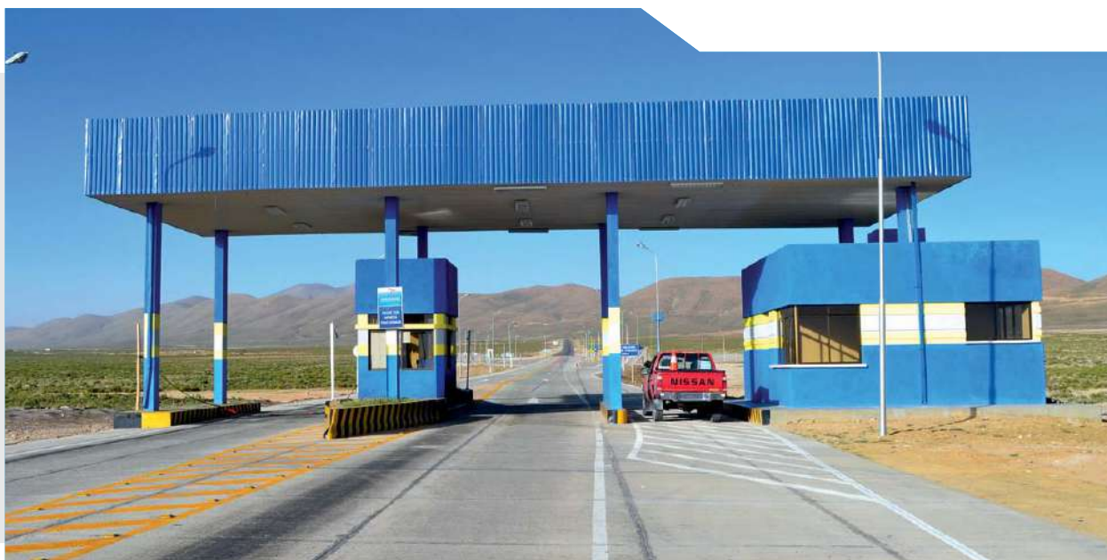
Estación de peaje Uyuni, en el departamento de Potosí, que controla la ruta Uyuni-Potosí.
