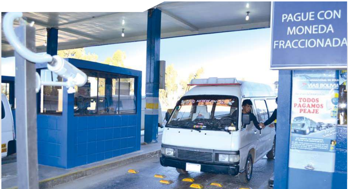
Estación de Peaje equipada con tecnología del Sistema de Cobro Automatizado de Peaje
